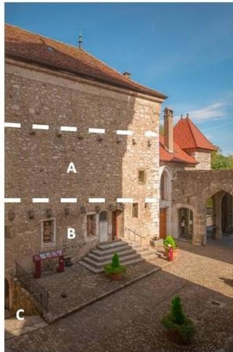
Vue depuis la cour
