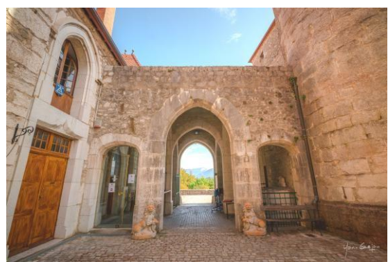
L'entrée principale, vue depuis la cour
